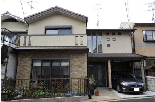
2軒であった家をつなげ、1軒にして使われていた住宅。途中で増築も行われ、構造が継ぎはぎの状態に隣地との基礎の取り合い、増築部分の軸組みで天井高が低くなる等の問題で若干プラン変更したが、以前の建物形状を残し施工
